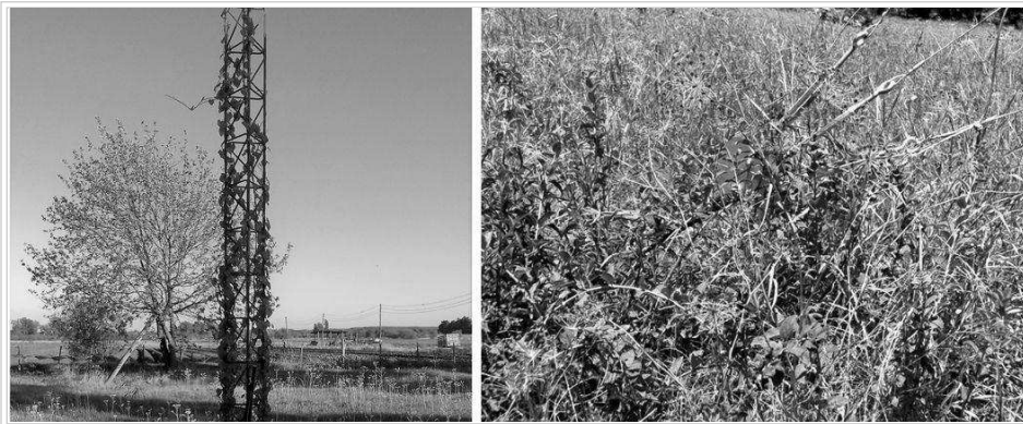
Fig. 8 - Ejemplos de vegetación en componentes del mástil
