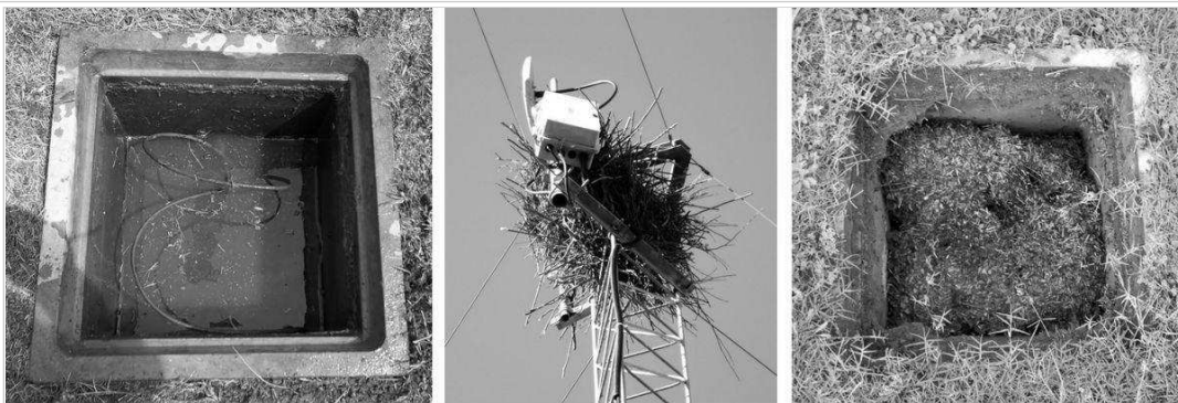
Fig. 4 - Limpieza y retiro de objetos extraños
