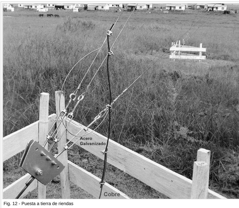
Fig. 12 - Puesta a tierra de riendas
