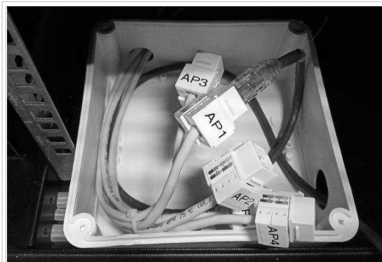
Fig. 5 : Interior de caja con jacks
