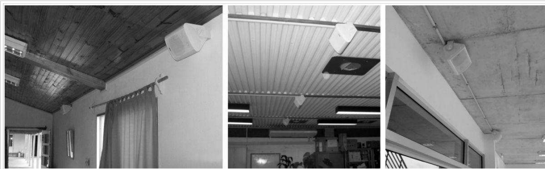
Fig. 10 : Ejemplos de instalación de parlantes.
