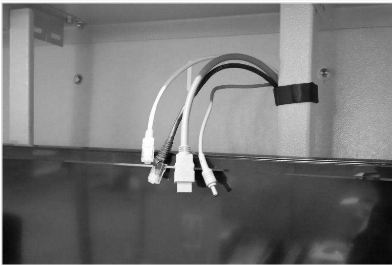
Fig. 4 : Preparación del cableado
