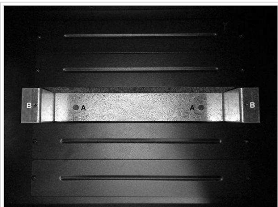
Fig. 2 - Fijación a piso Rack 19" 22U
