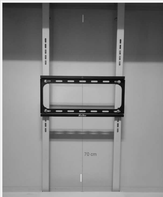
Fig. 14 : Fijación de soporte al gabinete.
