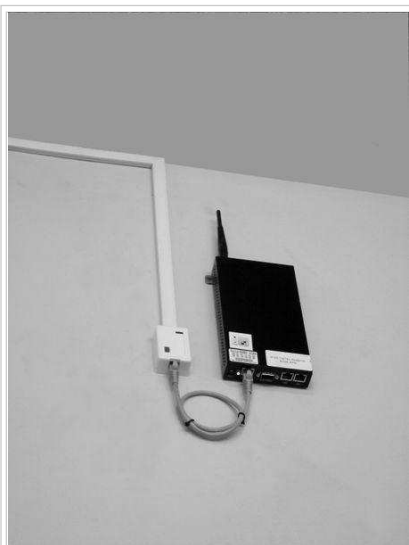
Fig. 1 - AP Mikrotik interior
