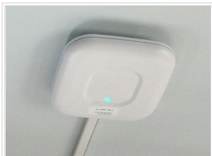
Fig. 2 - AP Cisco fijado a cielorraso común
