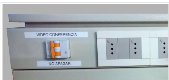
Fig. 2 : Derivación de VC desde rack 19" 20 o 25 U.
