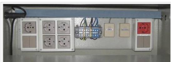
Fig. 4 : Bandeja eléctrica con bornera
