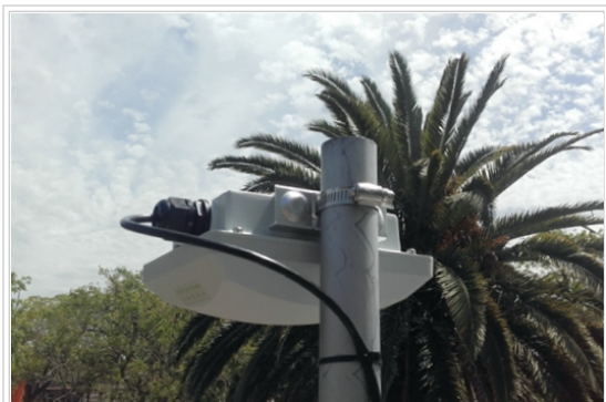
Fig. 1 - Equipo Ruckus T300 fijado a caño
