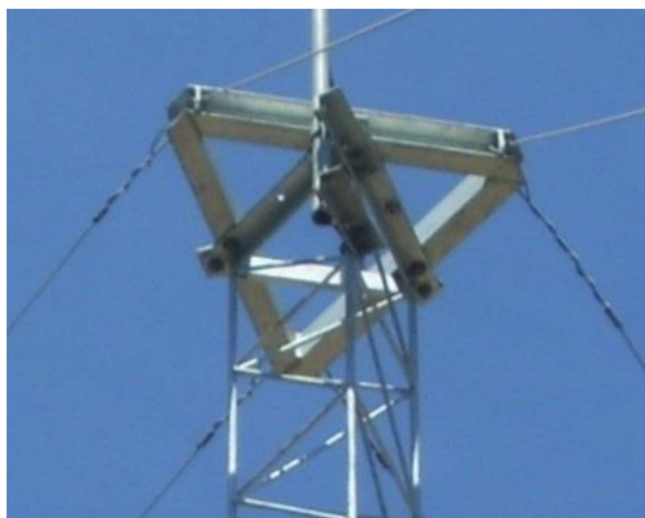
Fig. 2 – Detalle de estrella antitorsión
