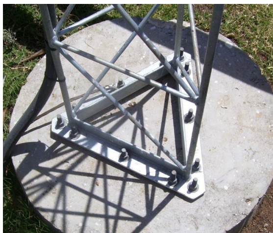
Fig. 1 – Detalle de extremo base / unión de tramos
