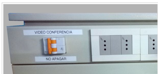
Fig. 3 : Derivación de VC desde rack 19" 20 o 25 U.
