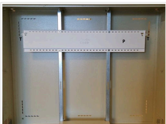
Fig. 2 : Instalación de platina de montaje.
