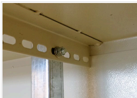
Fig. 1 : Ajuste de posición de parantes.
