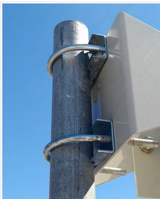
Fig. 3 - Fijación del soporte al caño
