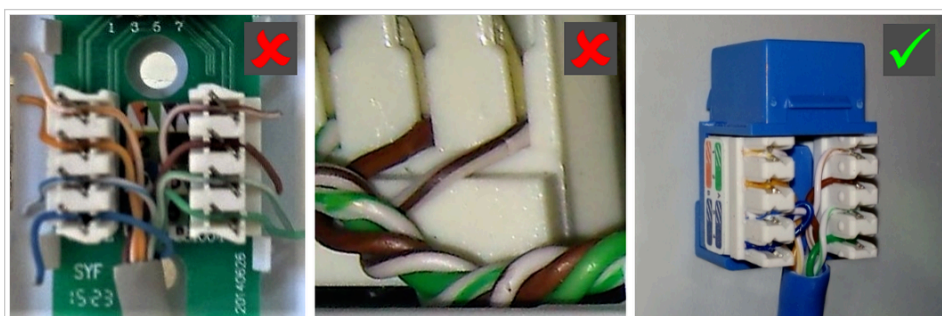
Fig. 5 - Crimpeado de jacks
