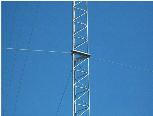
Fig. 3 – Unión entre tramos
