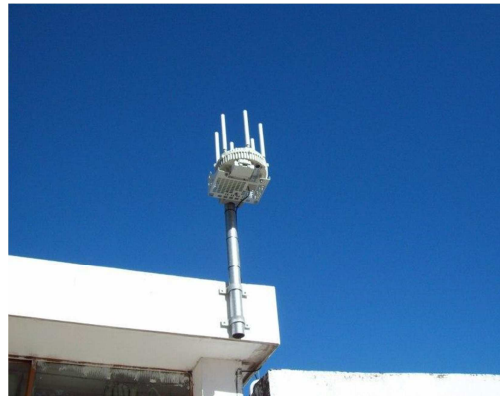
Fig. 14 – Instalación en caño amurado
