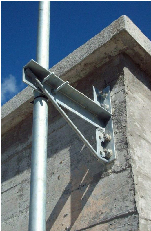
Fig. 11 – Instalación en caño amurado
