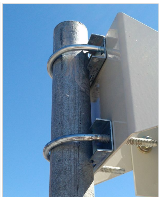
Fig. 3 - Fijación del soporte al caño
