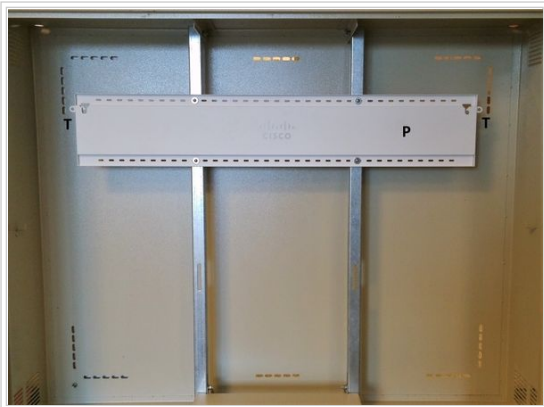
Fig. 2 : Instalación de platina de montaje.
