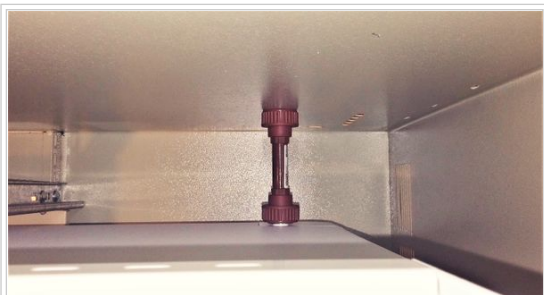
Fig. 4 : Separador (S) colocado.
