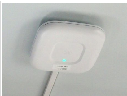
Fig. 2 - AP Cisco fijado a cielorraso común
